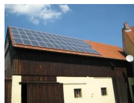
Tetto Elevato in Altezza
