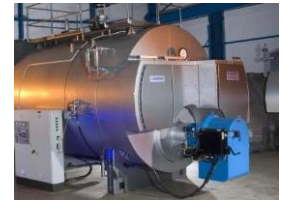
Pré-Aquecimento de Água de Alimentação para Caldeiras
