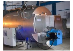
การอุ่นน้ำร้อนป้อน หม้อน้ำอุตสาหกรรม
