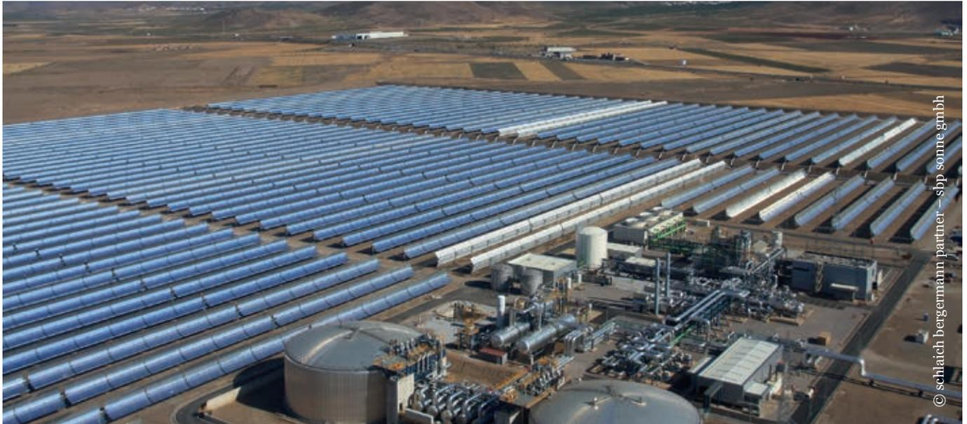
Central de cilindros parabólicos de 50 MW Andasol con colectores Euro Trough (toma aérea).
