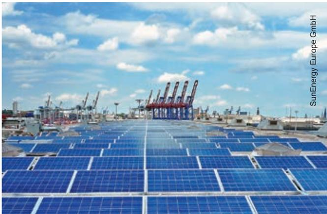
Puerto de Hamburgo: central solar instalada sobre tejado en colaboración con el proveedor de energía ecológica Hamburg Energie, 125 kWp.
