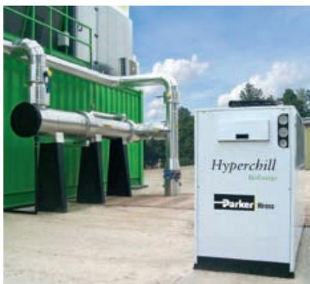
Sistema de deshumidificación de biogás con refrigerador, separador de gotas (demister) y enfriador de agua.
