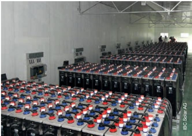
Bancos de baterías de un proyecto híbrido de fotovoltaica y diésel de 1,5 MWp en Senporna, Malasia. Capacidad de las baterías: 6,8 MWh.
