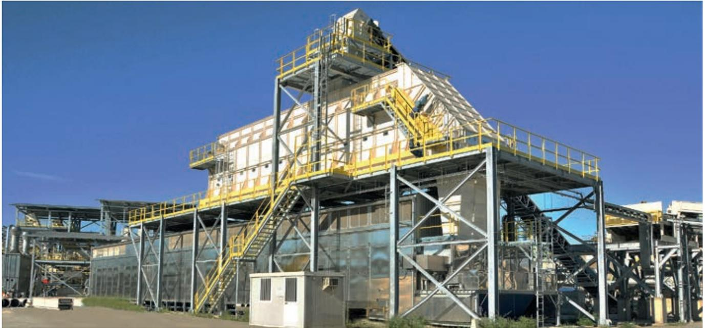
Secador a baja temperatura BT 1/6200-42 de Stela en Italia.
