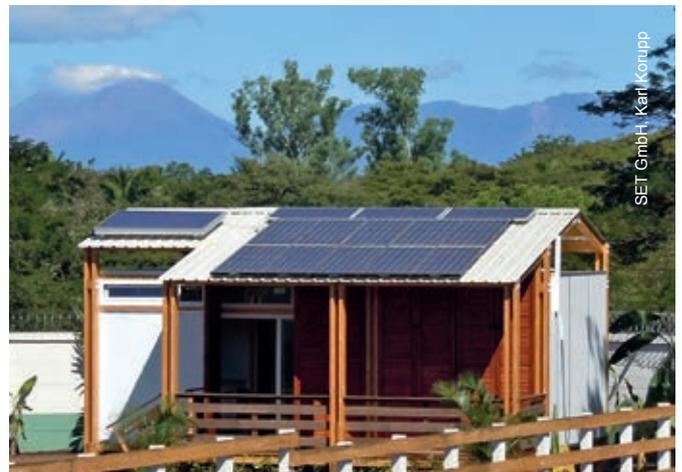
León, Nicaragua: los módulos fotovoltaicos sobre el techo de esta casa solar autosuficiente suministran electricidad con la que también se alimenta un sistema de bombeo solar. Colectores solares térmicos calientan el agua corriente.
